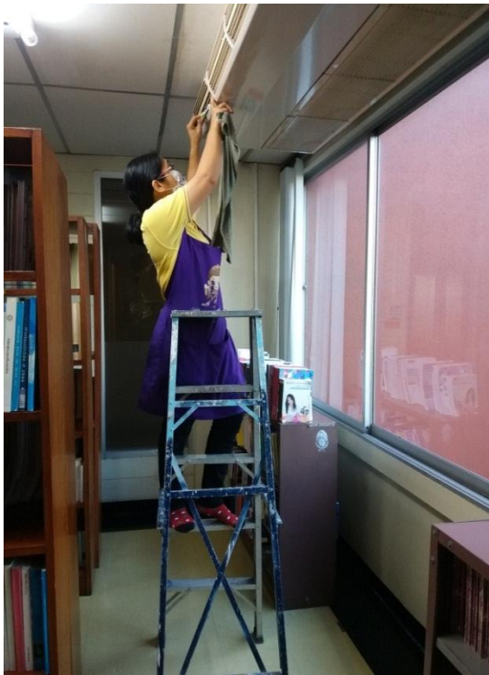
การทำความสะอาดแผ่นขดท่อคอยล์เย็น
