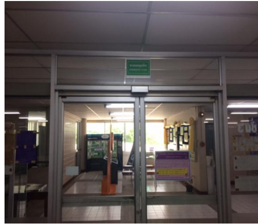
ทางออกฉุกเฉิน ชั้น 3 ลงด้านหน้า
